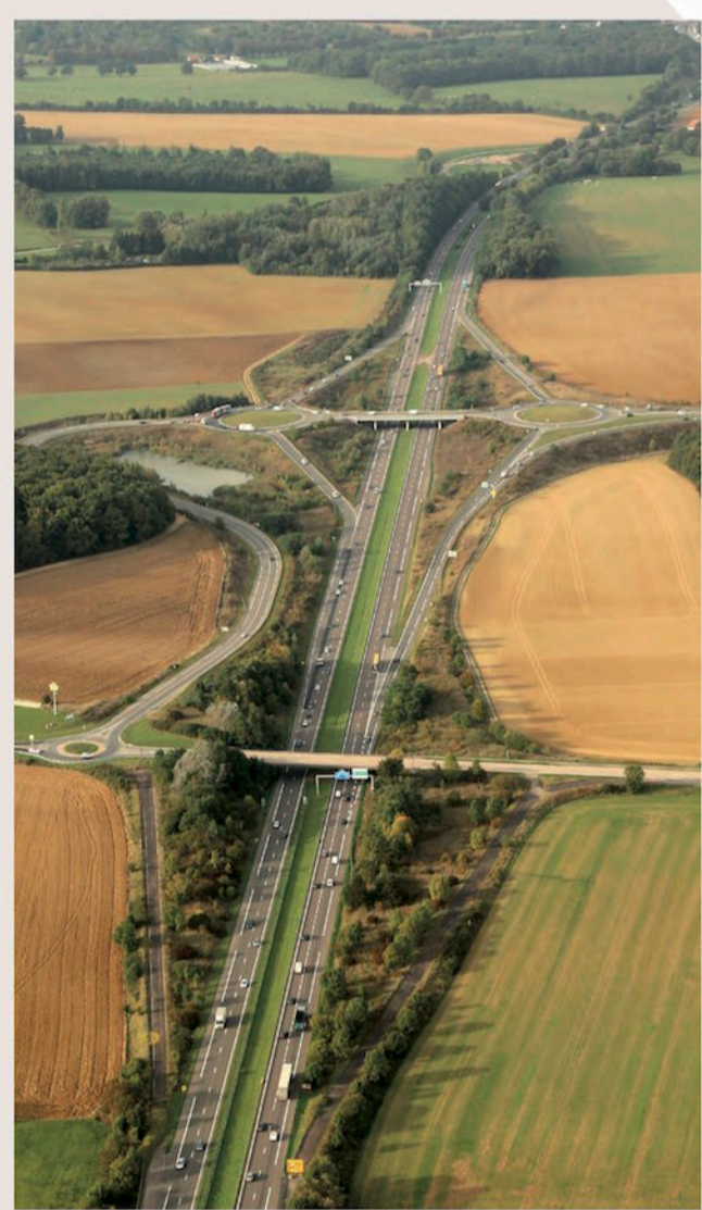
Echangeur sur l'A31 au niveau de Féy
