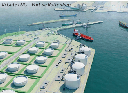
© Gate LNG – Port de Rotterdam
