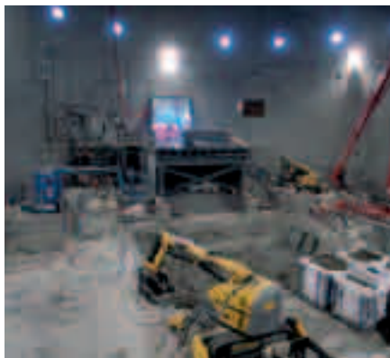
Le hall de Siloé en cours de démantèlement (Grenoble).
