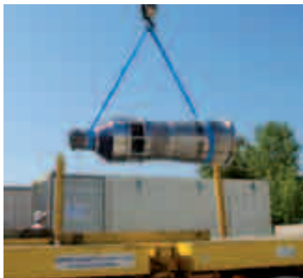
Chargement d'une pompe secondaire provenant du réacteur Phénix (Marcoule).
