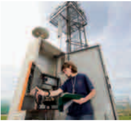
Station météorologique : prélèvements atmosphériques.
