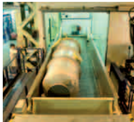
Démantèlement de l'usine de production d'uranium enrichi.
