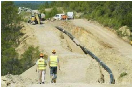
Les 300 km de canalisation entre l'Oise et la Haute-Marne seraient enterrés à « au moins 1 m » de profondeur.
