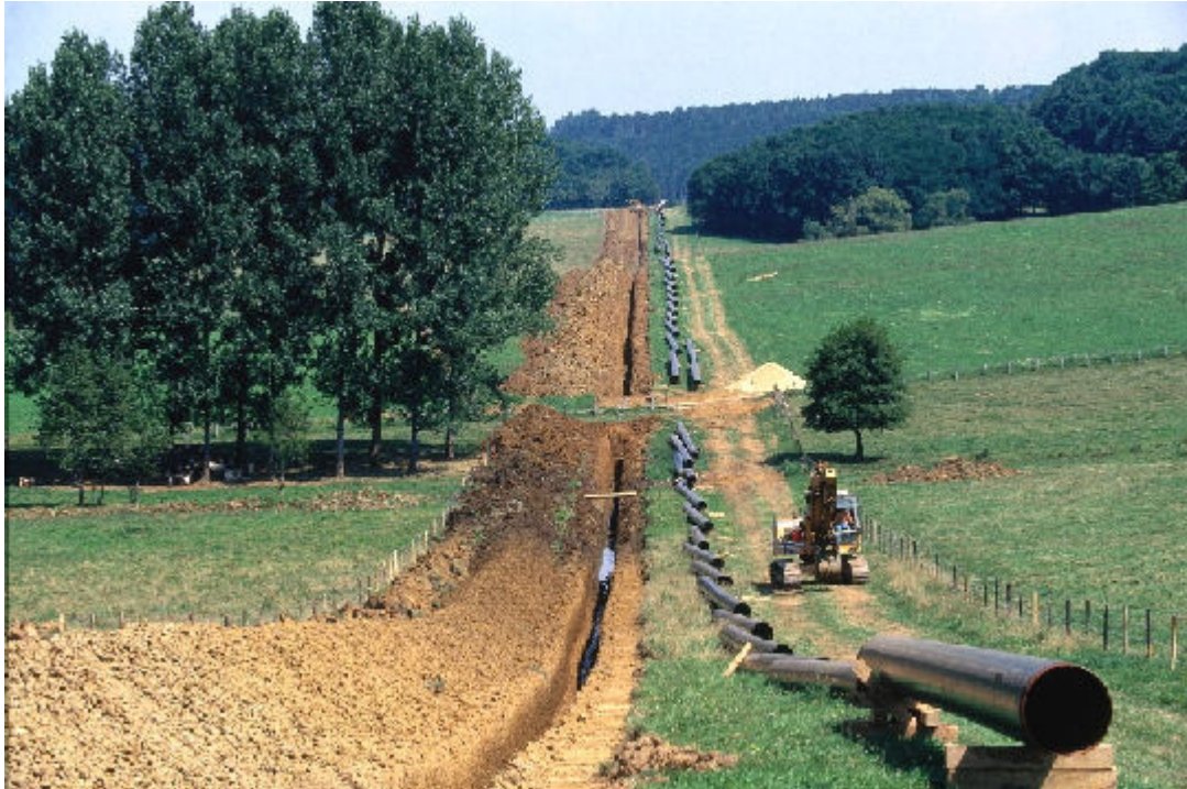
La pose d'un gazoduc entre Voisines (Haute-Marne) et Dambenois (Doubs). Photo © L'Espace Photo Gaz de France Suez - Roland Bourget. Source : Journal du Net .
