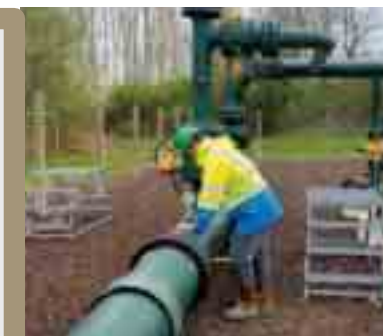
⚡ Contrôle du passage du piston instrumenté
