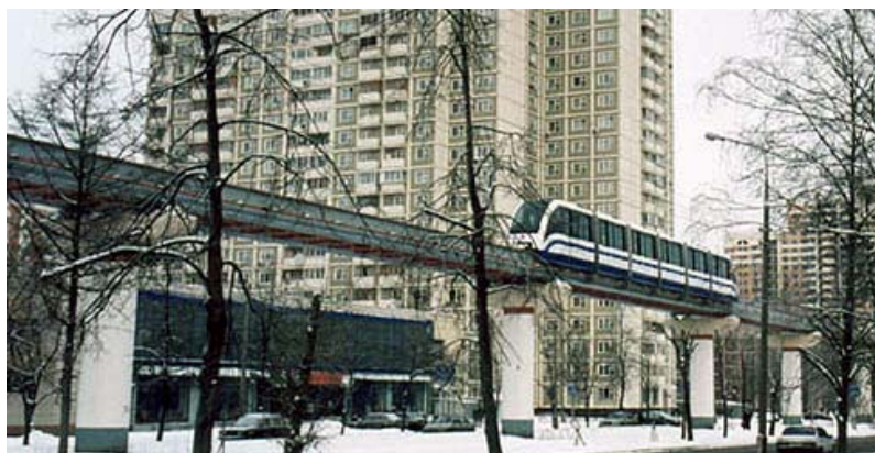
Le monorail de Moscou assure une desserte urbaine sur 4,7 Km et 6 stations entièrement en viaduc. Il a une capacité d'environ 6 000 voy./h.
