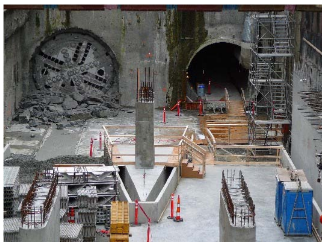
Vancouver – Canada Line : sortie du tunnelier à hauteur de la station Waterfront
