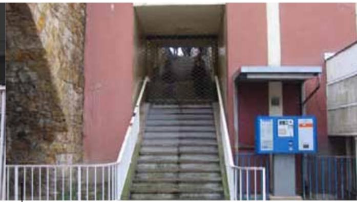
3: Accès condamné au souterrain depuis le chemin de la Gare
