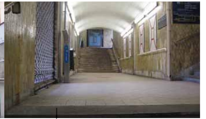
4: Accès aux quais par le souterrain
