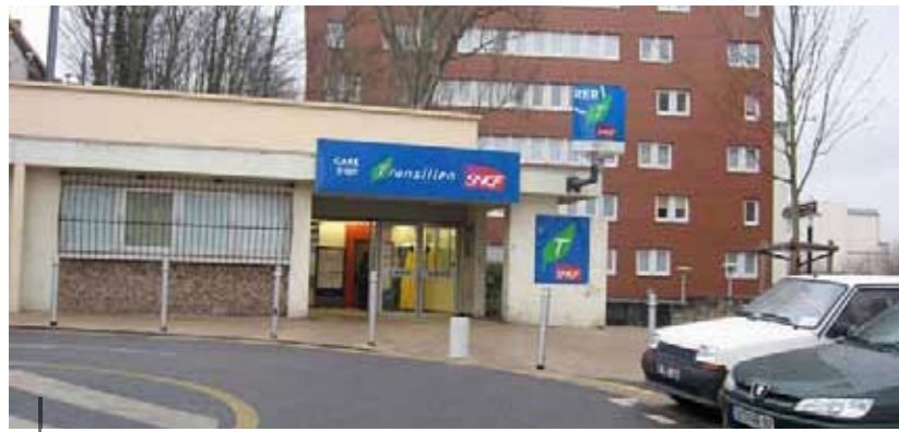
1: Accès Principal au BV depuis le chemin de la Gare
