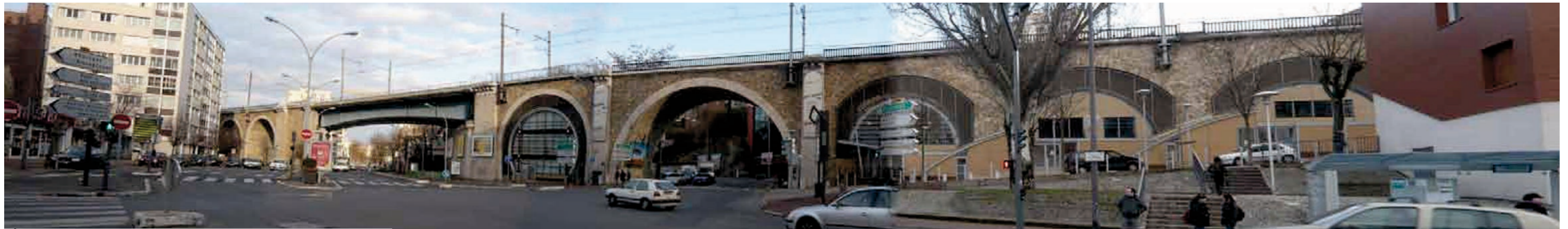
1: Viaduc franchissant les Avenues Pasteur et Victor Cresson
