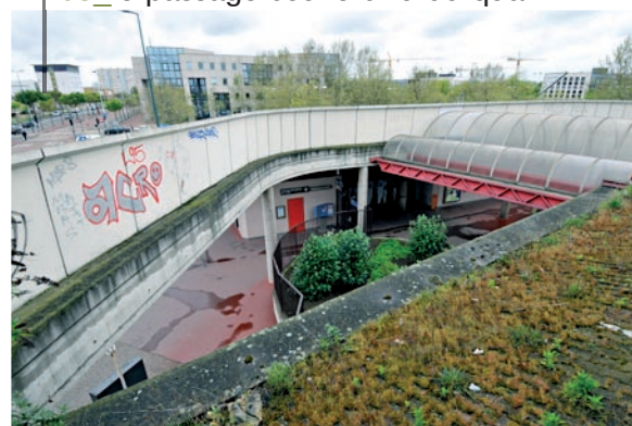
05_ le passage couvert vu du quai 2
