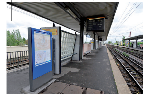
07_ le quai 1 encombré par le mobilier
