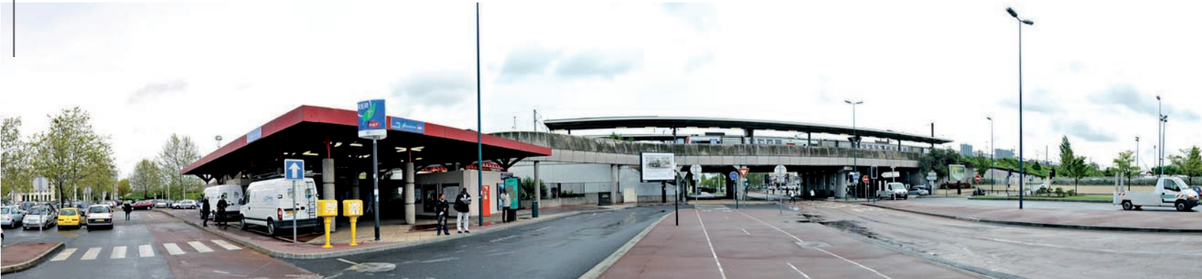
01_la gare vue depuis l’avenue du Général de Gaulle, au premier plan le BV, au second les quais en viaduc
