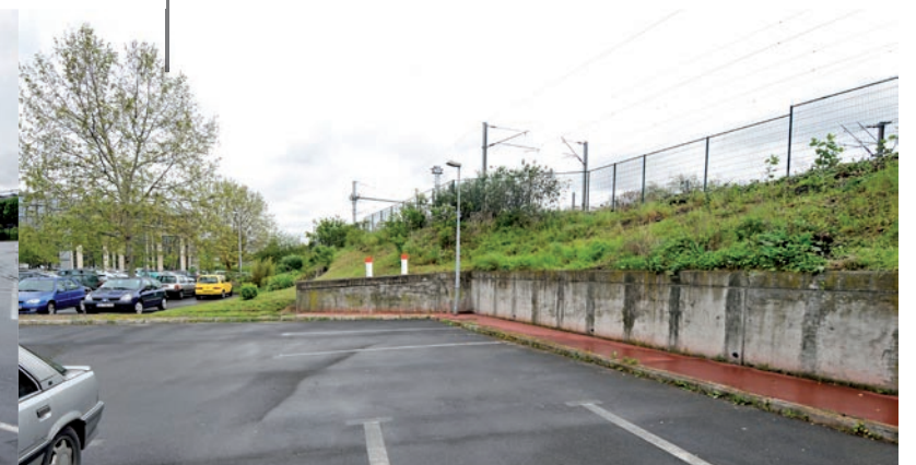
08_Talus entre parking et voies
