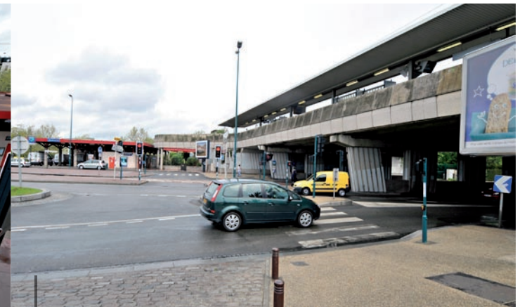
04_Le pont ferroviaire sur l' Avenue
