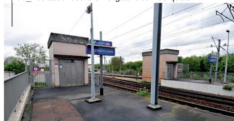
06_ les ascenseurs émergeant sur les quais
