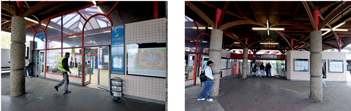
02_03_l'accès au bâtiment voyageur et au souterrain depuis l'abri jouxtant l'avenue
