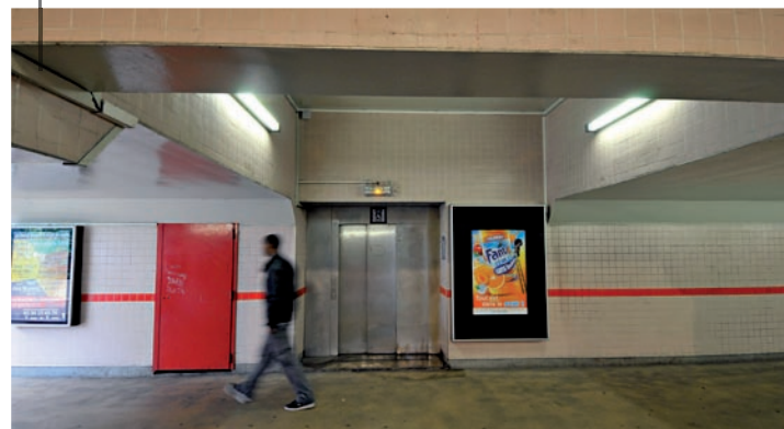
02_ascenseur accédant au quai 2
