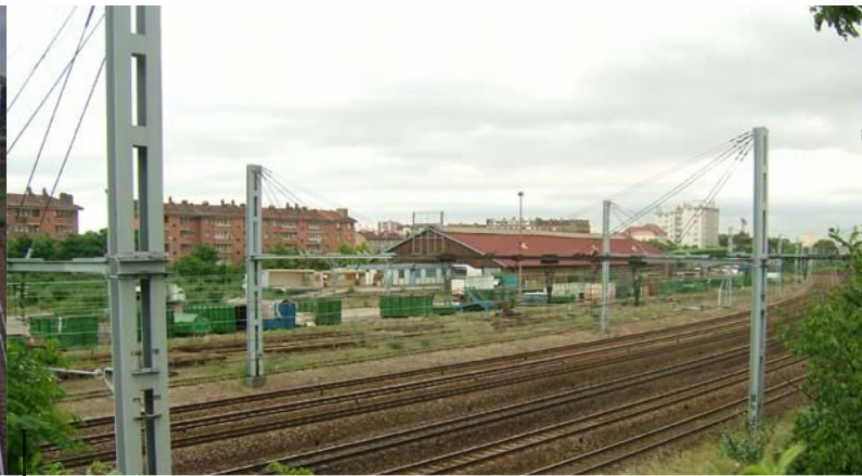
02_ Un grand entrepôt occupe la partie centrale de l'espace RFF/SNCF
