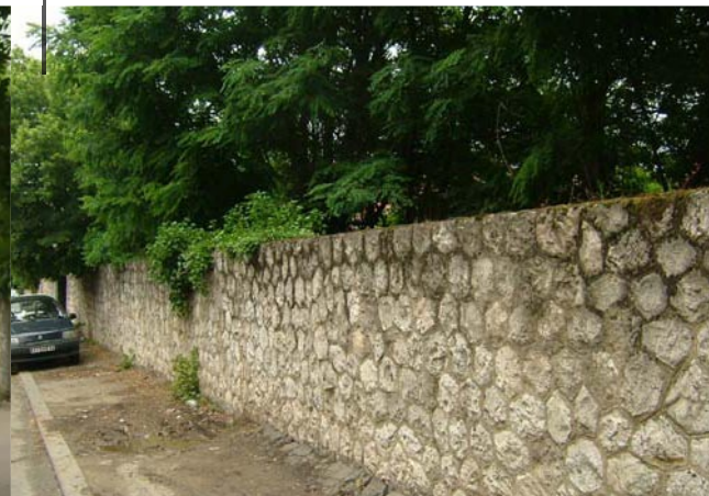
07_ Mur d'enceinte Rue de Verdun
