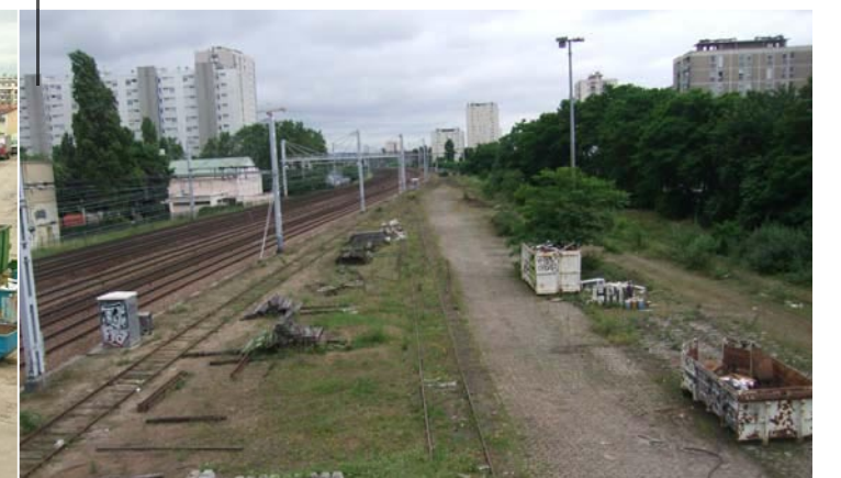
08_Espace vacant derrière le Boulevard Gallieni
