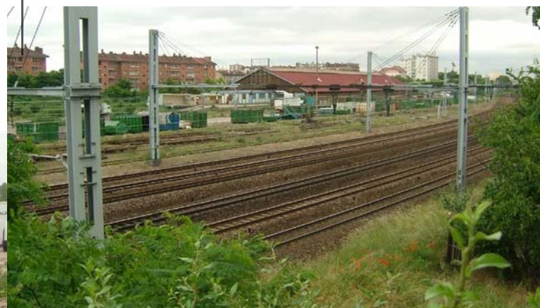
06_Pas d'accès existant pas le Boulevard Gallieni
