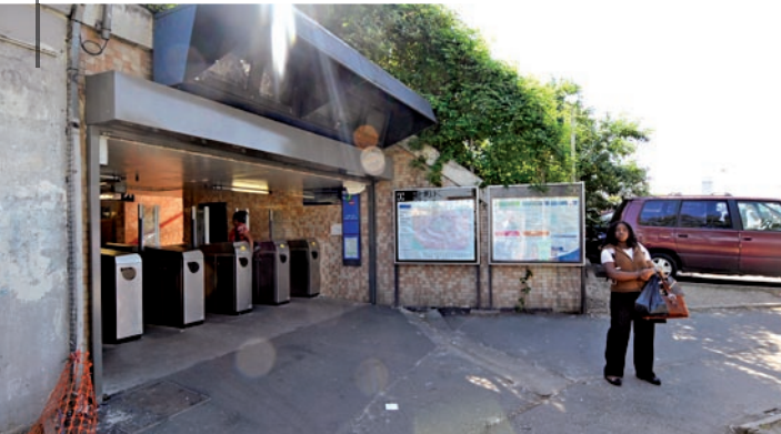
03_Accès aux quais depuis la Rue C. Michels
