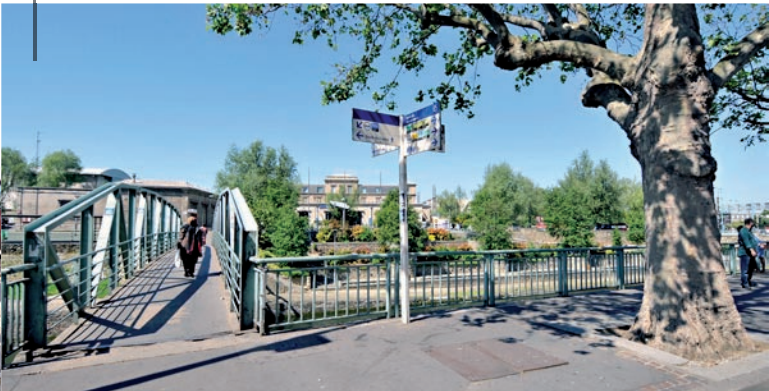
04_Passerelle piétone sur le canal St-Denis
