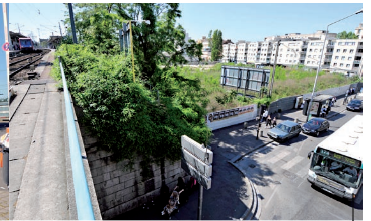
04_ Pont ferroviaire et espace libre pour le projet urbain
