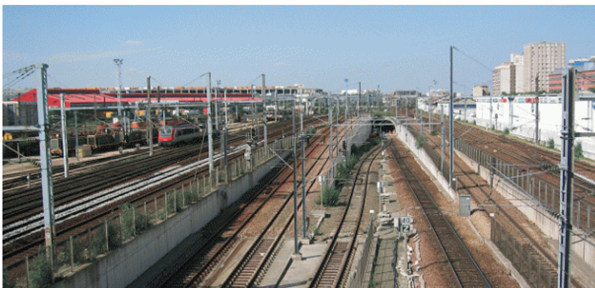
Le débouché du tunnel
