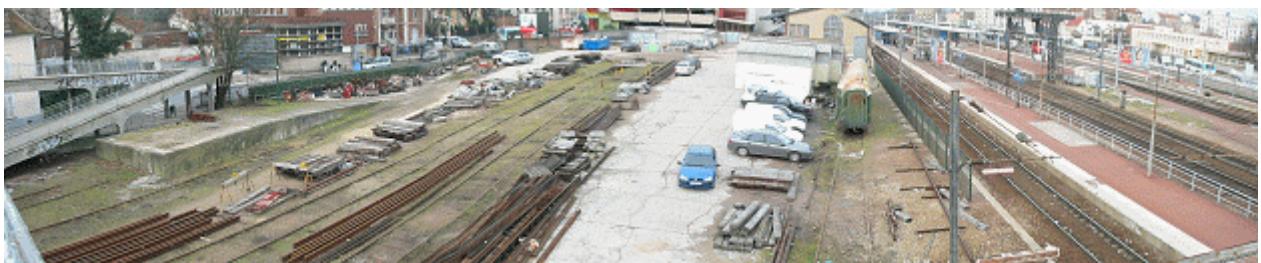
Gare d'Aulnay sous Bois et sa base travaux
