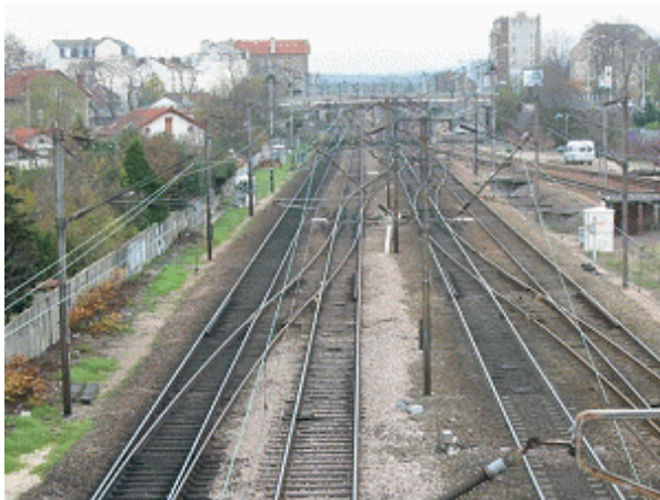
Entrée gare d'Aulnay sous Bois
