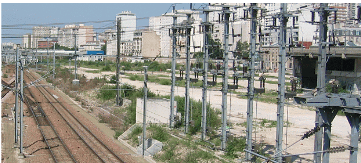
Le débouché futur du tunnel
