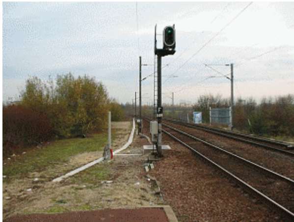
Entrée de la gare de Villepinte
