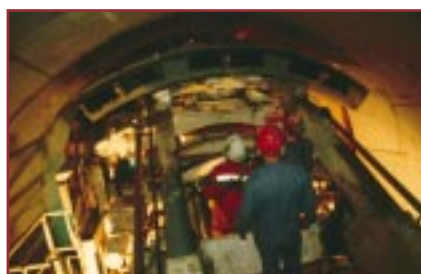
Mise en place d'un voussoir
