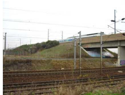
Figure 11 Vue de ce même endroit depuis un autre angle, avec le passage d'une rame TGV.
