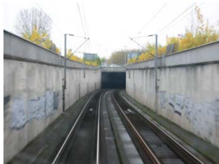
Figure 7 Entrée de la tranchée couverte de Sevrans-Beaudotte, dont le quadruplement s'avère difficile
