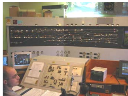
Figure 9 Poste de commande de Aulnay
