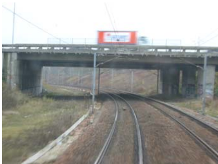
Figure 6 Entre Roissy et Servan, les ouvrages d'art sont conçus pour accueillir une infrastructure à 4 voies
