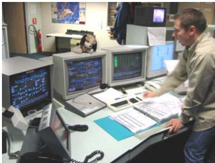
Figure 4 Poste de commande de CDG 2
