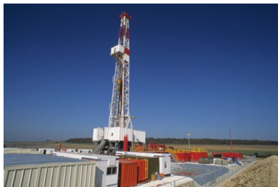
Plateforme de forage lors des campagnes de reconnaissances effectuées dans la Meuse/Haute-Marne
