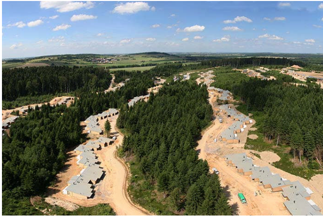
Chantier Center parcs Vienne
