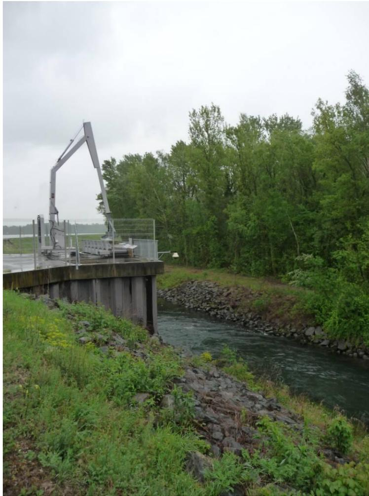
Figure 120 : Photo d'exemple de prise d'eau dans un cours d'eau – polders du Rhin – Mai 2010 (source : EGIS)
