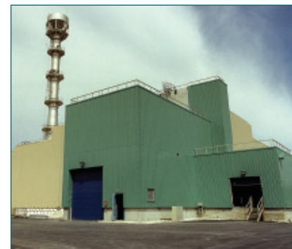
Installation d'entreposage (ECC) à La Hague
