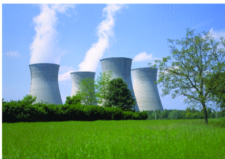
Centrale du Bugey - Médiathèque EDF
