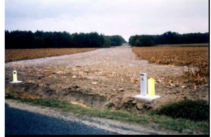
Photo prise 2 mois après la fin des travaux (12/10/89)
