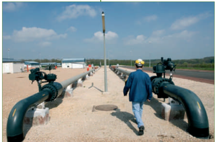
Poste de comptage
