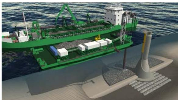
En mer, un ensemble de navires spécialisés prépare une souille de 45 x 100 m, empierrée, sur laquelle la fondation est déposée. Les matériaux extraits pour la préparation du support sont remis en place autour de la fondation, de façon à limiter l'érosion de la base.
