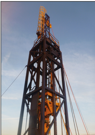
Exemple de tour de forage
