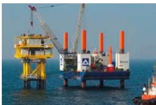
Figure 20 : Pose de la sous-station électrique (E.ON, 2010)
