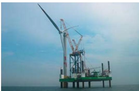
Figure 19 : Assemblage des éoliennes en mer sur les fondations (Journaldunet.com)
