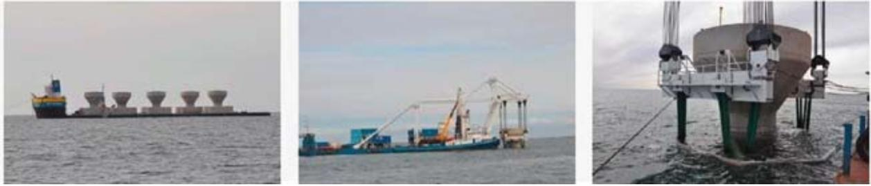
Figure 16: Transport des fondations vers le site, transporteur de colis lourds sur le site et installation d'une fondation (E.ON, 2010)
