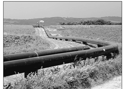
Préparation du gazoduc avant enfouissement.
