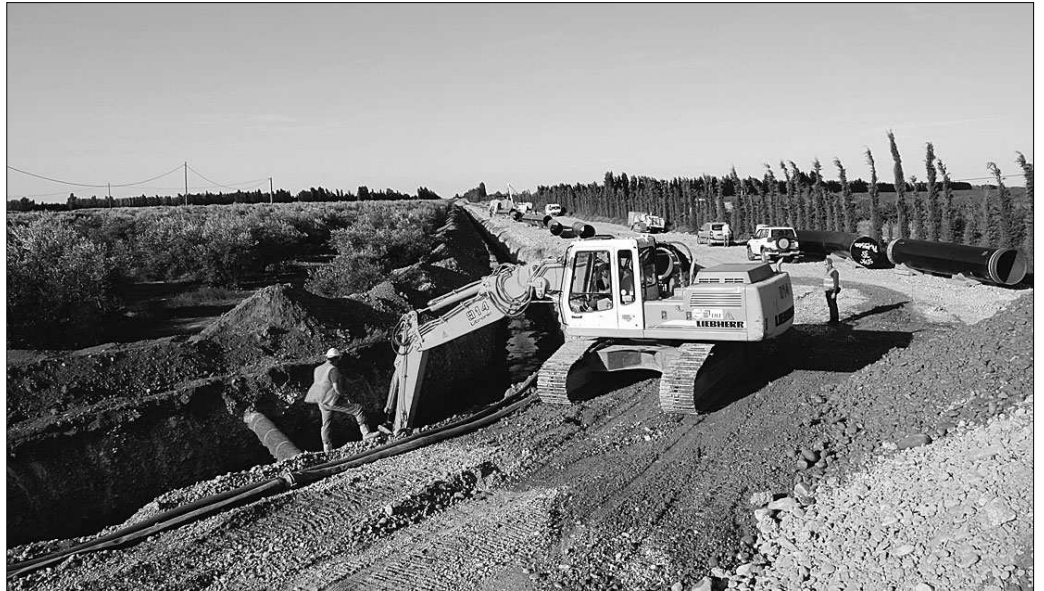
Si le projet de GRTgaz est validé, une saignée de 20 m de large sera faite dans le paysage, avant revégétalisation, pour installer les 200 km de canalisations long de la vallée du Rhône. Le gazoduc passerait en Tricastin et à l'est de Montélimar dans la plaine de la Valdaine.
