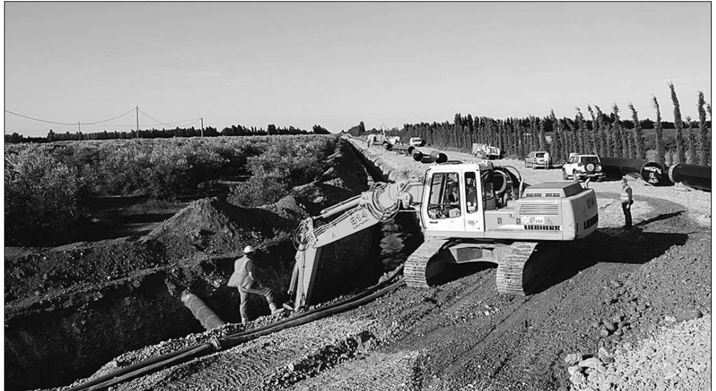
Si le projet de GRTgaz est validé, une saignée de 20 m de large sera faite dans le paysage, avant revégétalisations, pour installer les 200 km de canalisations le long de la vallée du Rhône. Le gazoduc passerait en Tricastin et à l'est de Montélimar dans la plaine de la Valdaine.
