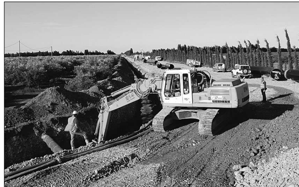
Ouverture de la tranchée - chantier Fos St Martin.
