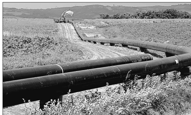
Préparation du tube soudé avant enfouissement - chantier Serpaize les Haies.
