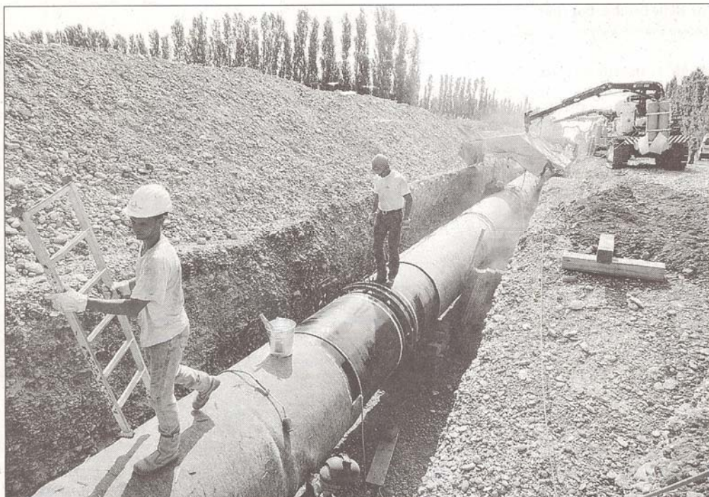
► Après la plaine de Crau où un pipeline a été enfoui en 2006, en bordure de la RN 568 (photo), une nouvelle conduite est en projet au départ de la station de compression de Saint-Martin. / PHOTO FRÉDÉRIC SPEICH
