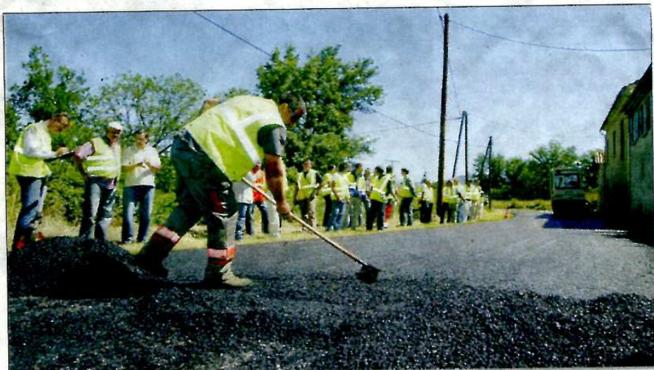
► La Ménudelle enrobés (LME) souhaite fabriquer elle-même ses enrobés avec les stocks invendus de cailloux issus de la carrière. Ce produit servira à la construction des chaussées. / PHOTO ARCHIVES LA PROVENCE
