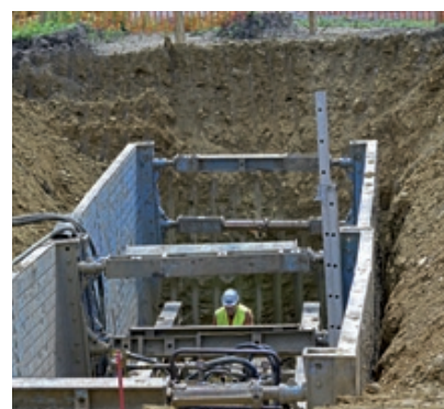
» Le franchissement en sous-œuvre
