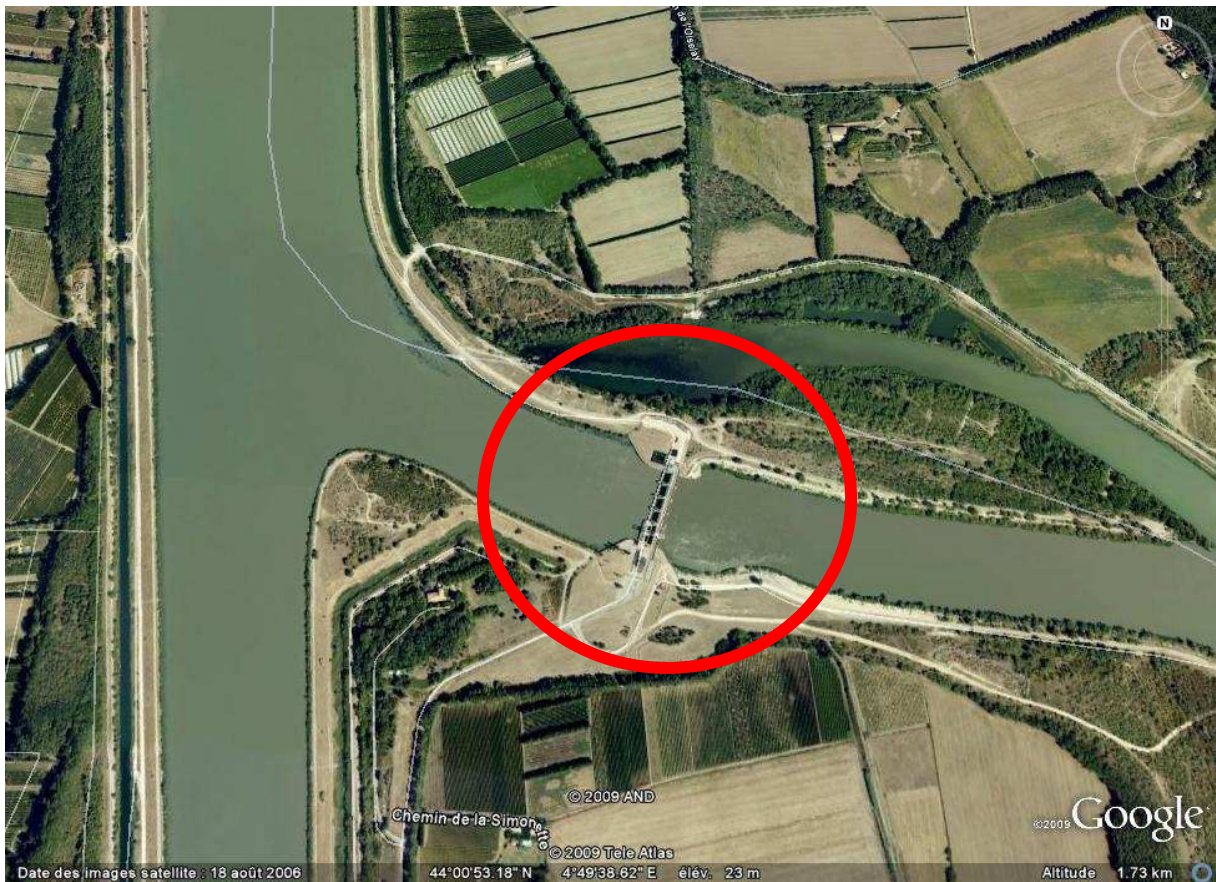
Vue du barrage sur le bras Est du Rhône
