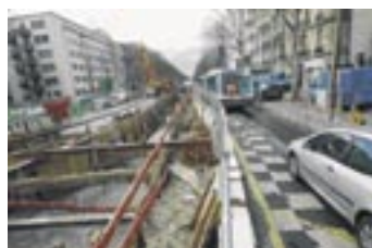
Exemple de travaux du tramway des Maréchaux Sud.
