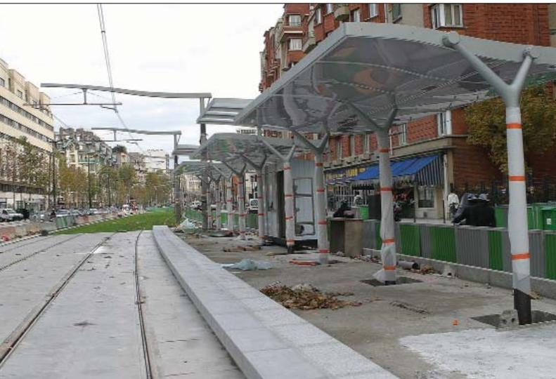
Les portes-LAC ( Lignes Aériennes de Contact) sur le tronçon en cours de réalisation, entre le pont du Garigliano et la porte d'Ivry
