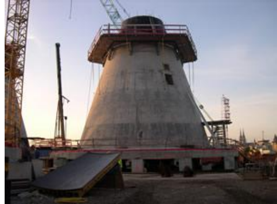
Coffrage et coulage
