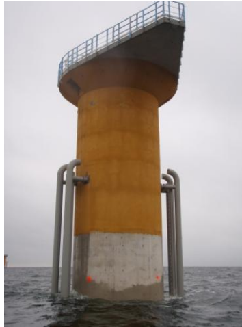
Figure 9: Forme d'accostage et plateforme de travail – C- Power, 2008 (EDF-EN)
