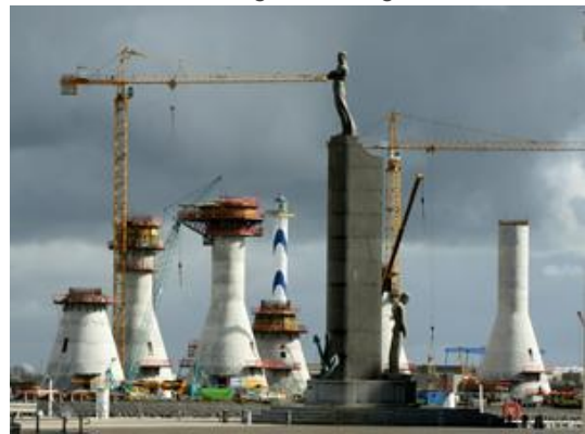
Construction simultanée des 6 fondations
