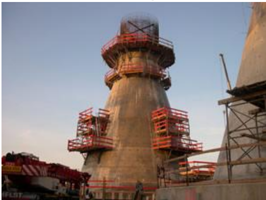
Coffrage et coulage
