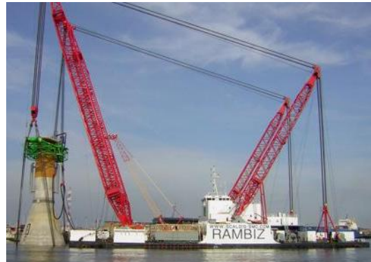
Transport au site d'installation
