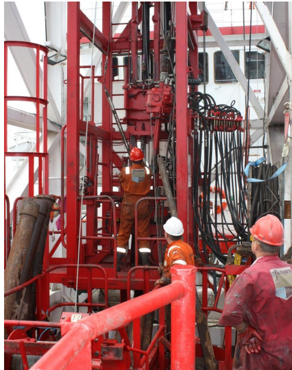
Figure 3: Opération de carottage sur le Fugro Commander
