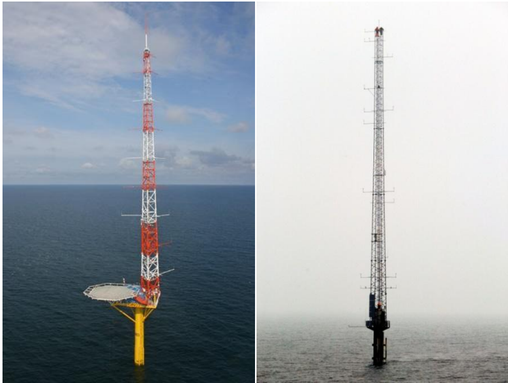
Figure 11 : Mâts de mesures de vent : FINO3 à gauche, sur le parc de Horns rev 1 (DONG Energy) à droite
