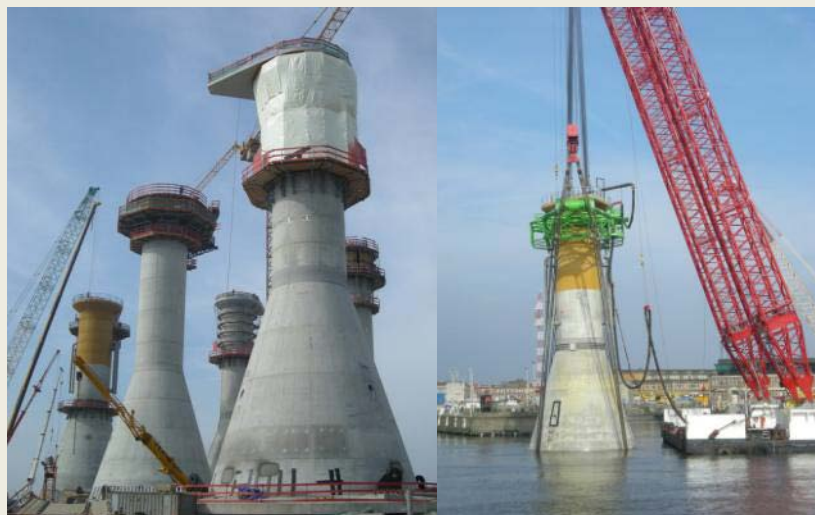
Fondations: Fabrication et installation (au Havre)
