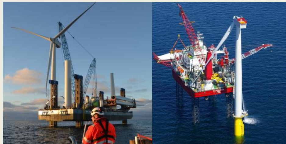
Eoliennes: Assemblage et installation (au Havre)
