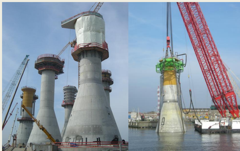
Fondations: Fabrication et installation (au Havre)
