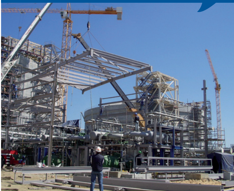
Phase de construction d'un terminal méthanier
