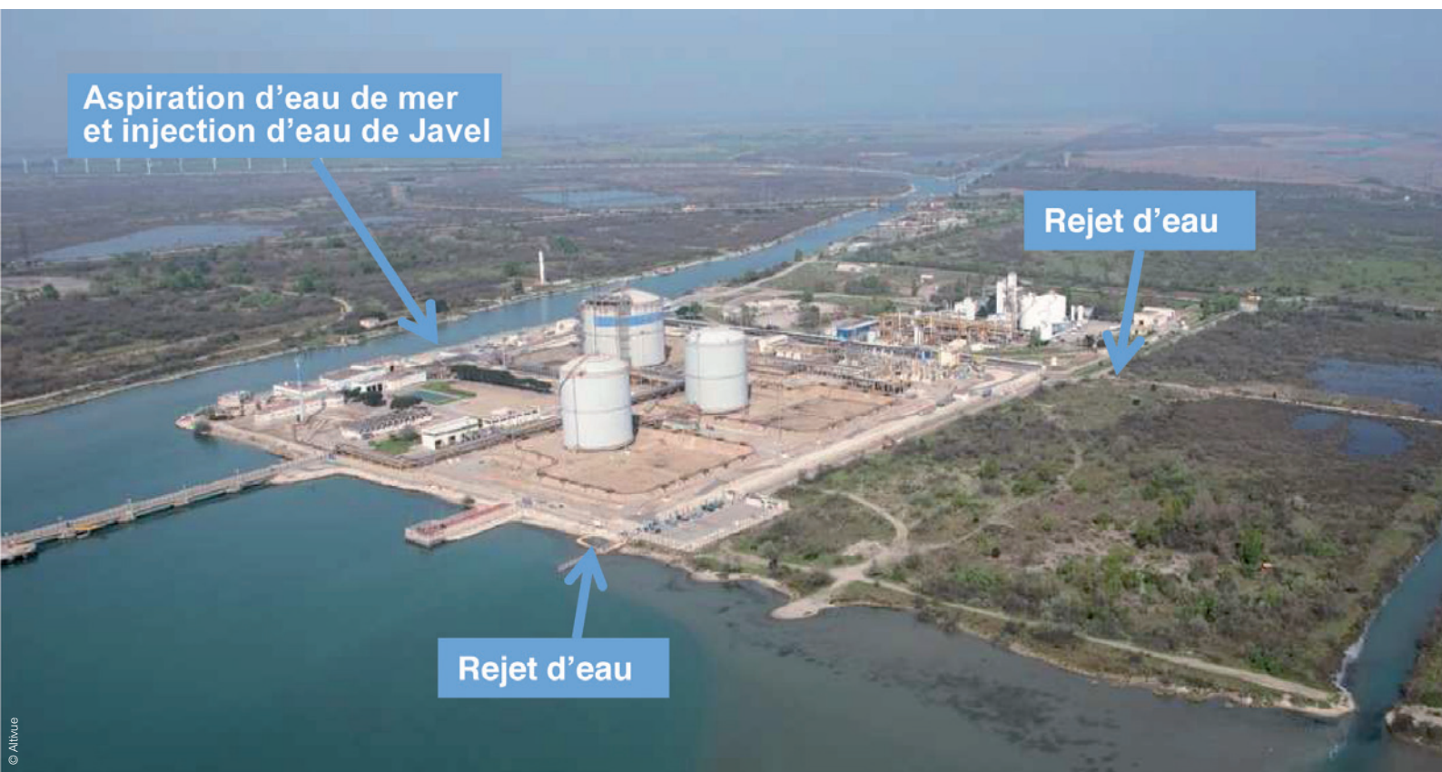
Localisation de l'injection de l'eau de Javel et des points de rejets d'eau de mer sur le terminal méthanier de Fos Tonkin.
