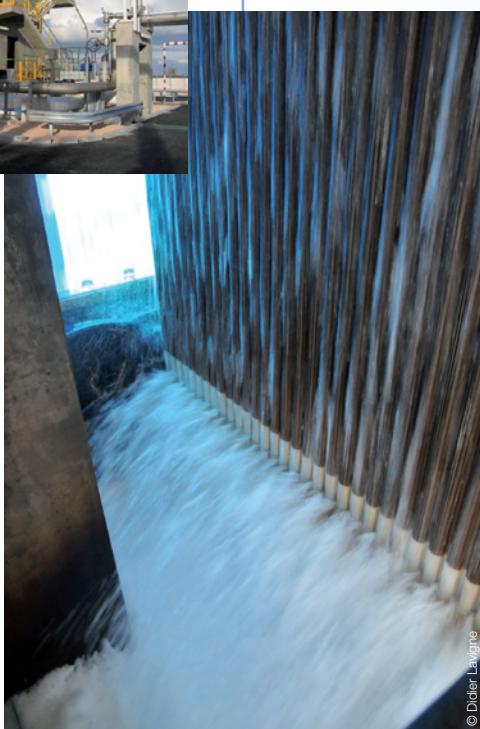
Regazéifieur et ruissellement d'eau le long d'un panneau.
