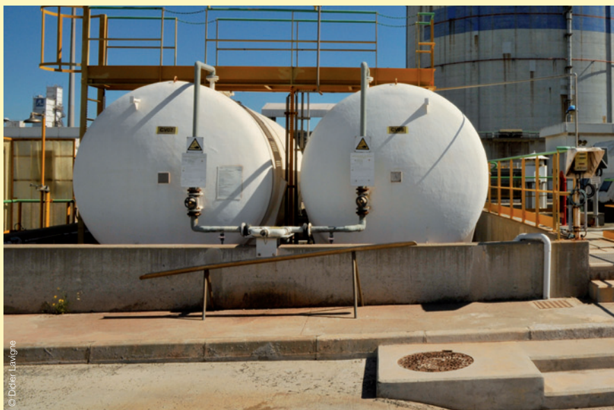
Réservoirs d'hypochlorite de sodium du terminal méthanier de Fos Tonkin
