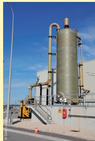
Réservoir d'hypochlorite de sodium (produit par électrochloration) du terminal méthanier de Fos Cavaou
