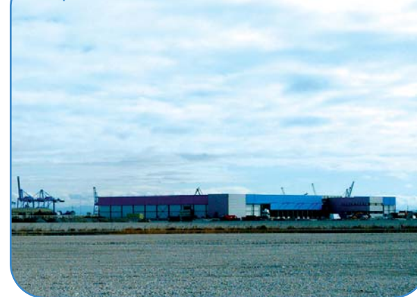
Distriport : bâtiments « Léon-Vincent » en construction
