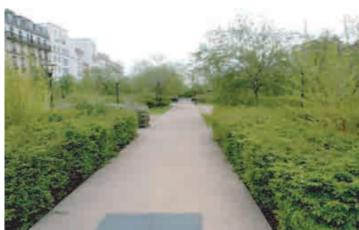
Aménagement d'une tranchée couverte en milieu urbain
