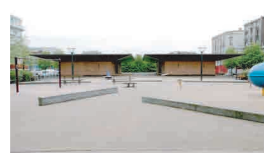
Locaux de ventilation des tunnels
