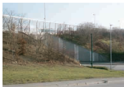
Remblais avec protection phoniques
