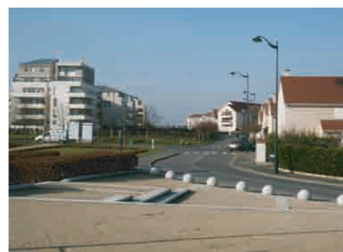
Aménagement d'une tranchée couverte en milieu urbain
