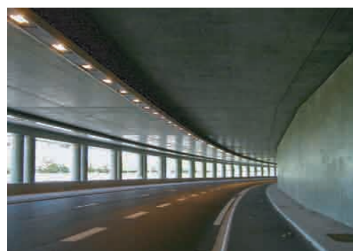
Section d'autoroute semi-couverte
