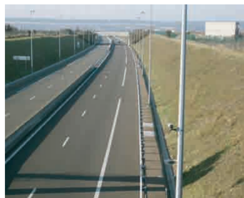
Section d'autoroute en déblai
