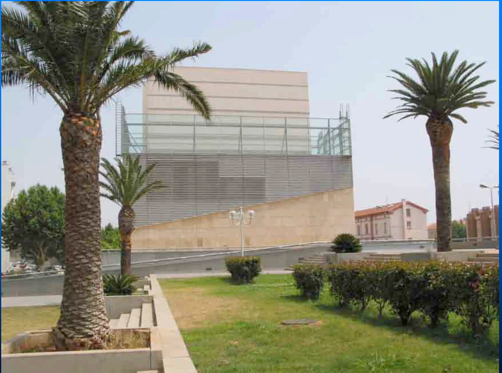
La ventilation sanitaire des tunnels
