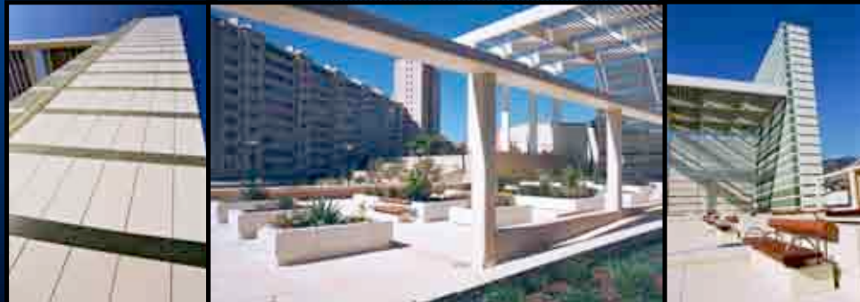
La ventilation sanitaire des tunnels
