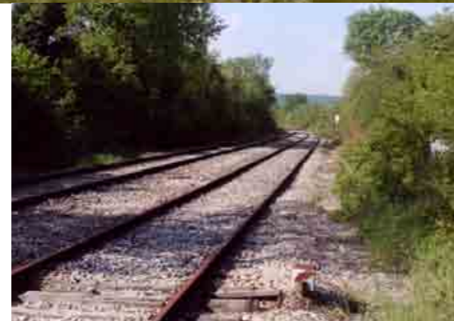
PLAINE DE VERSAILLES La tangentielle ferrée ouest en attente de réouverture depuis 1995.
