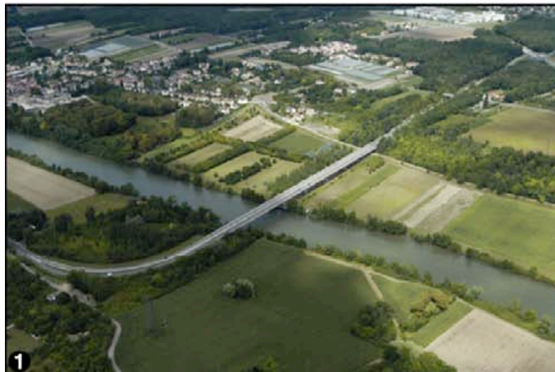
1 Franchissement existant de l'Oise.
