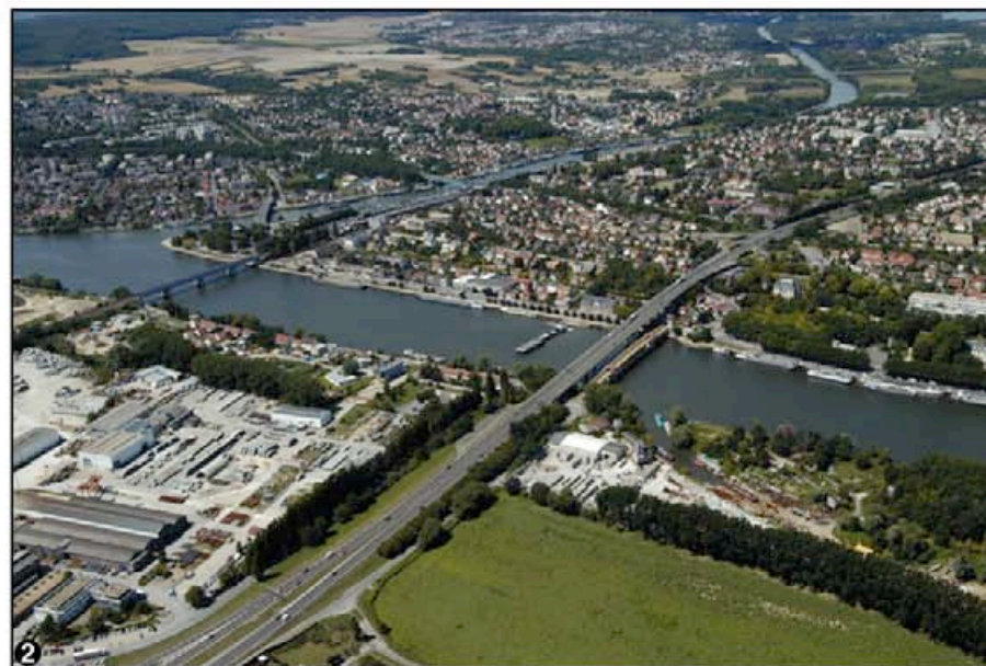
Franchissement existant de l'Oise.
