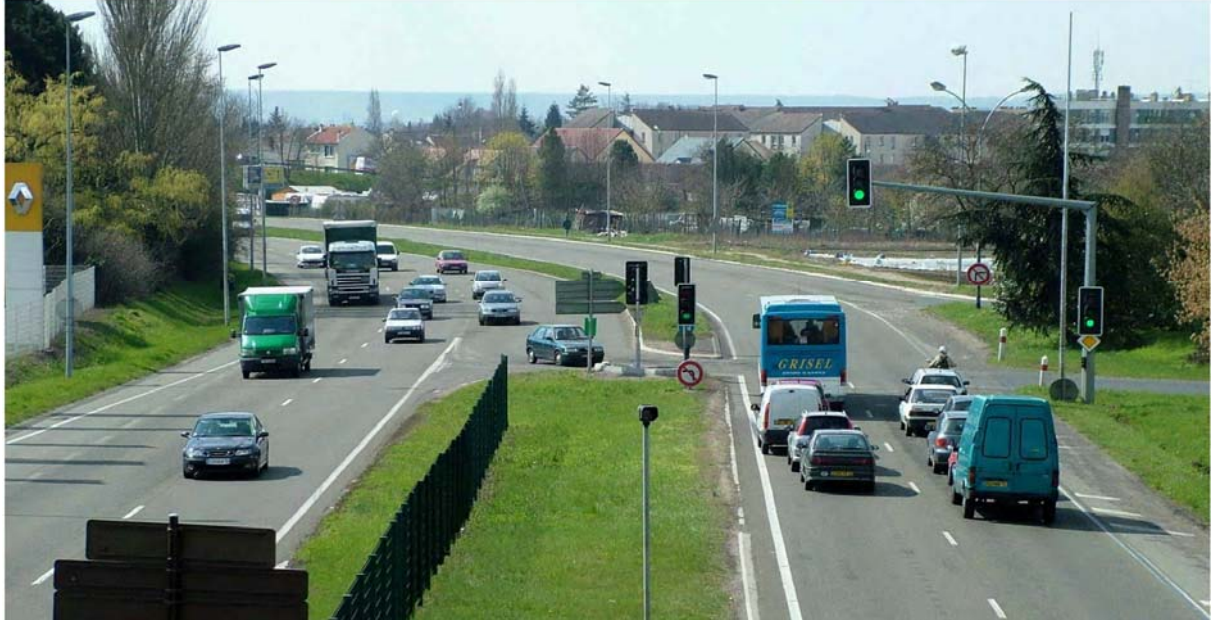
n° 40a. Carrefour RN184 - RD203 Ce vaste carrefour serait traité en demi - échangeur avec des ronds - points en surface.
