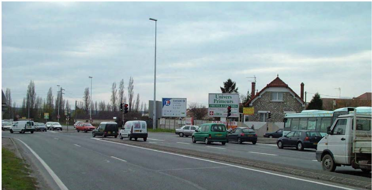
n° 46a. Carrefour RN184 - bd des Aviateurs Alliés Ce carrefour à niveau n'a pas de liaison directe avec la voie rapide. Sur la voirie locale, Il assure la desserte locale entre Conflans et Eragny.
