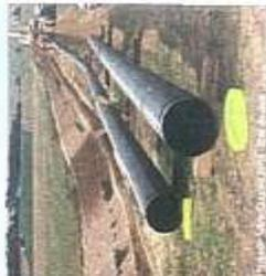
Après la mise en place de la canalisation, il faut effectuer des travaux de confortement de la tranchée.
