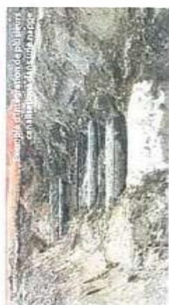
Après la mise en place de la canalisation, il faut effectuer des travaux de confortement de la tranchée.
