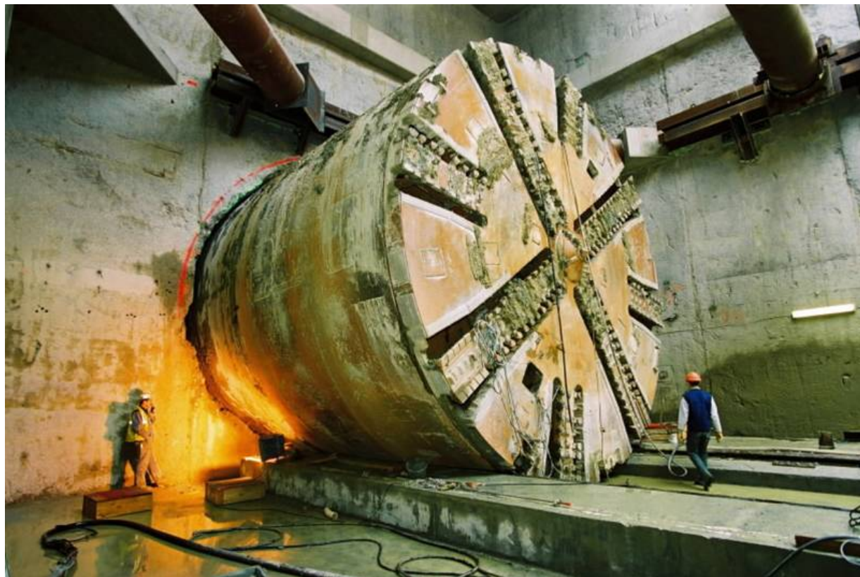
Photo : Tunnelier à pression de boue en cours de rentrée en station (Toulouse Ligne B)
