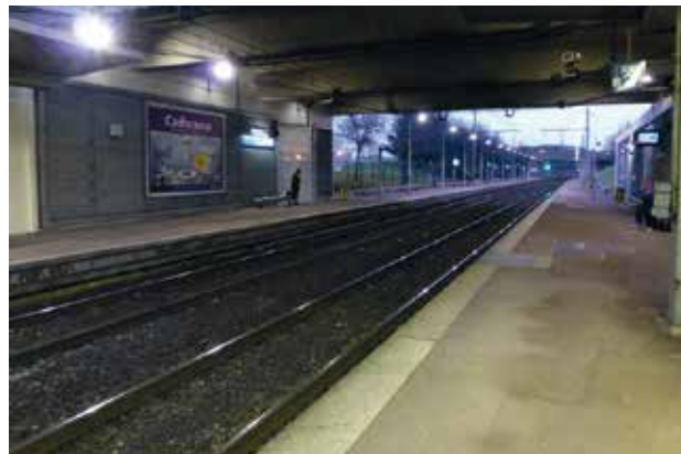
LA GARE D'ORANGIS BOIS DE L'ÉPINE : DE GROS AMÉNAGEMENTS SERONT NÉCESSAIRES
