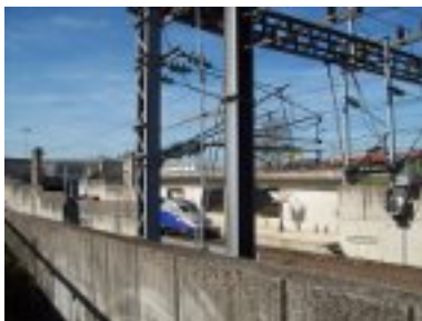
Extrémité est de la gare Massy TGV
