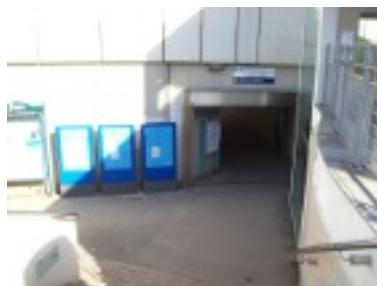
Souterrain piéton RER B et C Massy-Verrières
