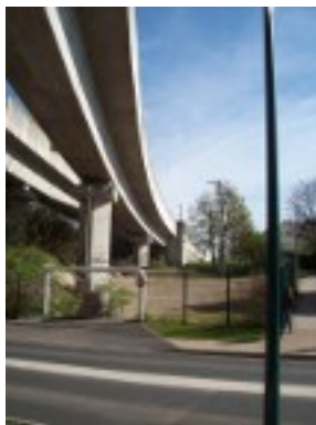
OH 905 vue depuis l'avenue du Général de Gaulle
