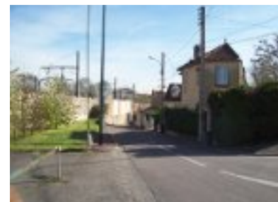
Raccordement Massy-Valenton le long de la rue Pierre Picard
