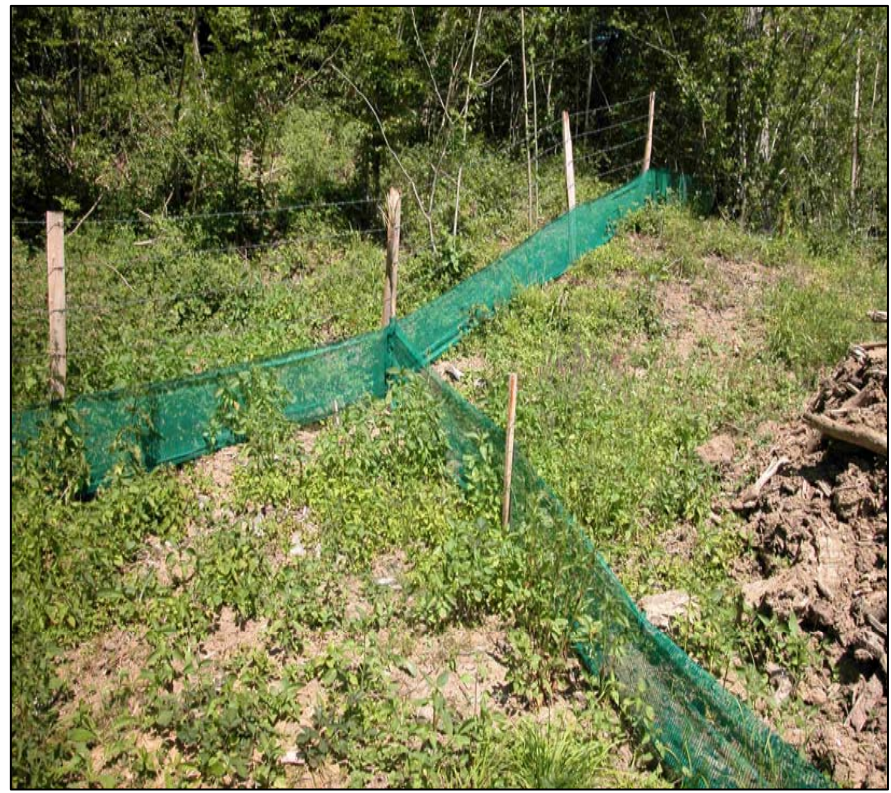
Filet de protection anti-batrancien.
