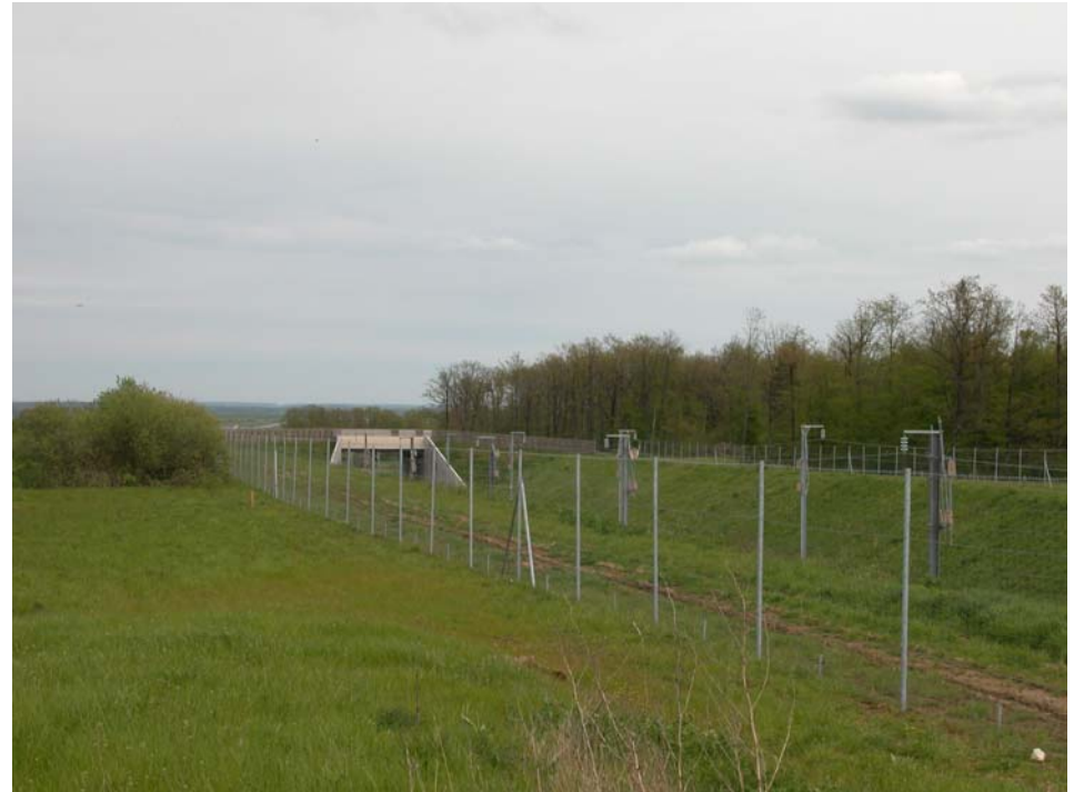
Clôtures grand gibier qui protègent des intrusions dans les emprises et dirigent naturellement vers les passages grande faune.
